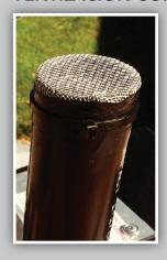
Este tubo de ventilación se cubrió con una malla fina (1/16 de una pulgada) v se aseguró con cinta eléctrica y cables plásticos.
