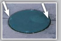
La falta de tornillos en la tapa puede causar un espacio que podría permitir que los mosquitos entren en el tanque séptico
