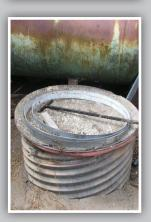
Este es un ejemplo de una tapa improvisada. La madera se ha torcido y no permite un sellado adecuado. La tapadera debe ser reemplazada con la cubierta recomendada para este estilo de tanque séptico.
