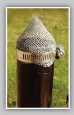
Este tubo de ventilación se cubrió con una malla fina (1/16 de una pulgada) y se aseguró con una abrazadera de manguera
